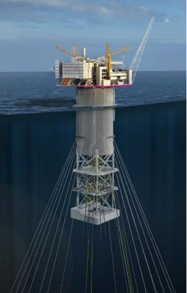
Aasta Hansteen & Hywind Scotland – one common technology: Spar
