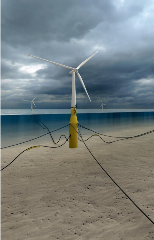
Aasta Hansteen & Hywind Scotland – one common technology: Spar
